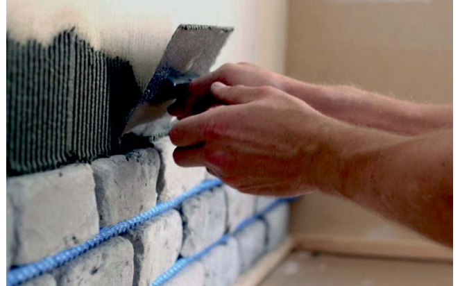
Käytä laastin levitykseen 8-9 mm piikkistä laastikampaa.
