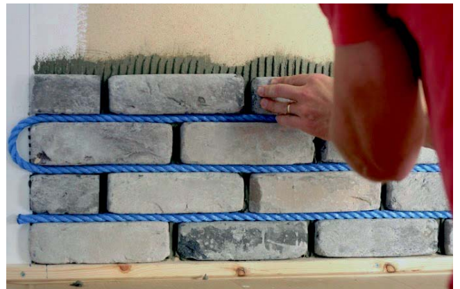
Köysi estää laattojen liikkumisen asennuksen aikana.
