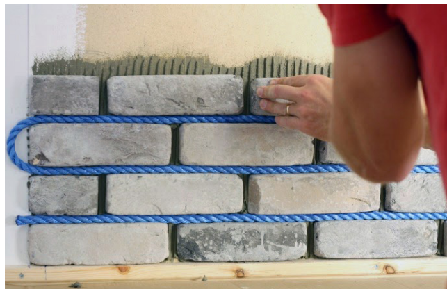
Köysi estää laattojen liikkumisen asennuksen aikana.
